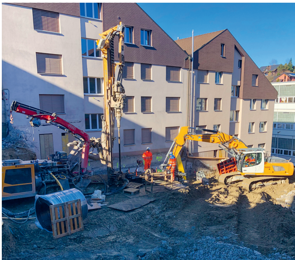
Baugrube mit schwerem Gerät
