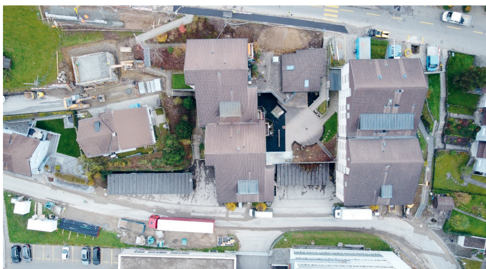
Überbauung Saumstrasse/Sturzeneggstrasse (Blick von Oben)
