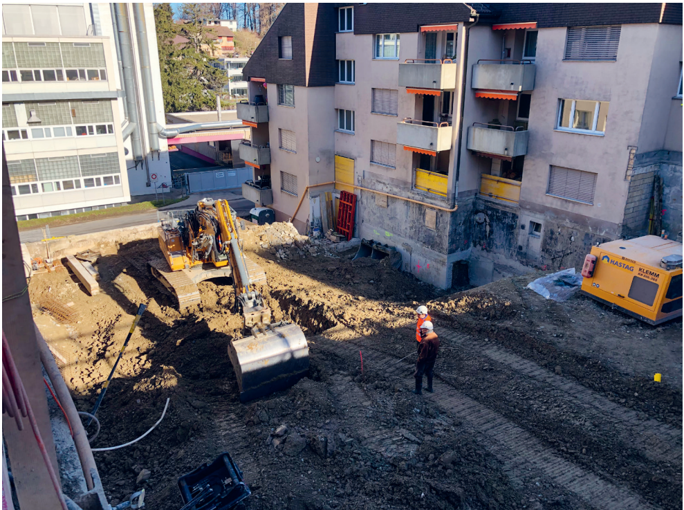
Baugrube von der Saumstrasse
