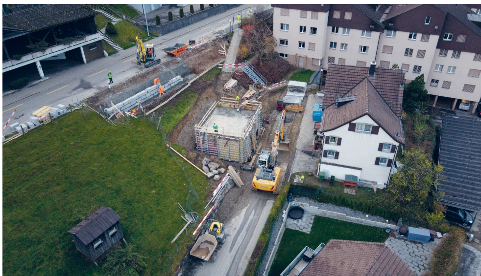
Neue Parkplätze Überbauung Saumstrasse/Sturzeneggstrasse (Blick von Osten)
