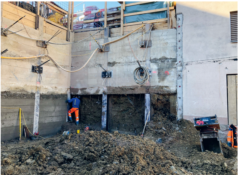
Ankerbohrung Richtung Saumstrasse
